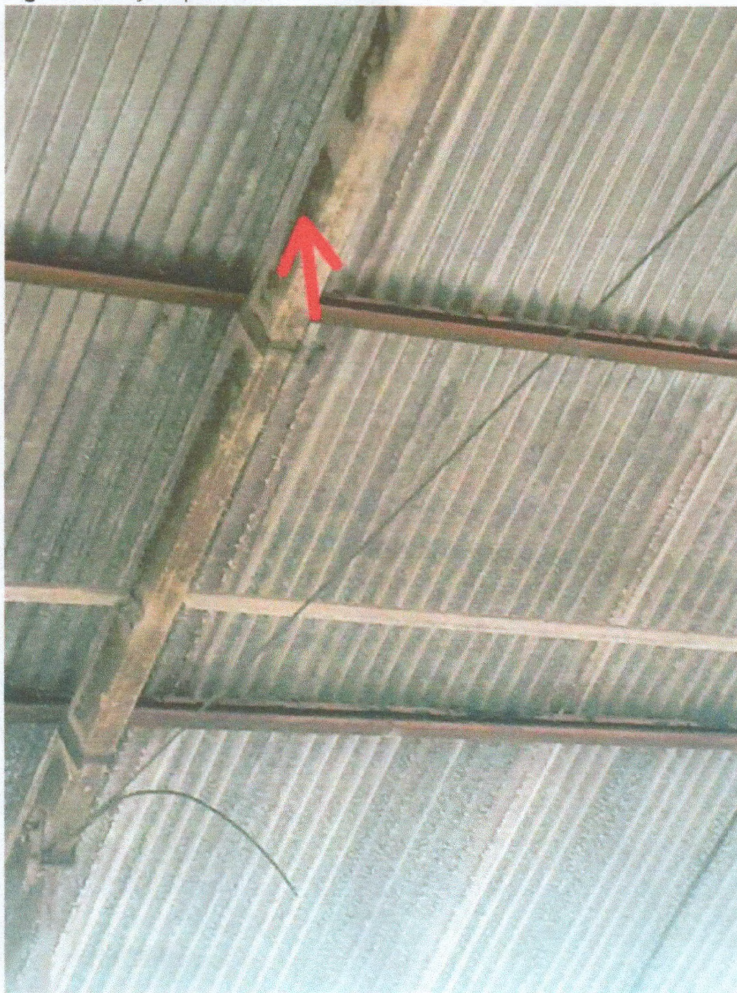
Figura 10. terça improvisada na cobertura
