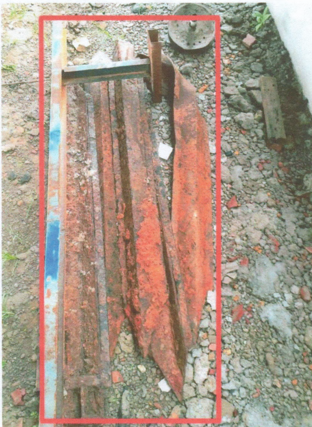
Figura 20. estacas de amarração dos cabos removidas.
