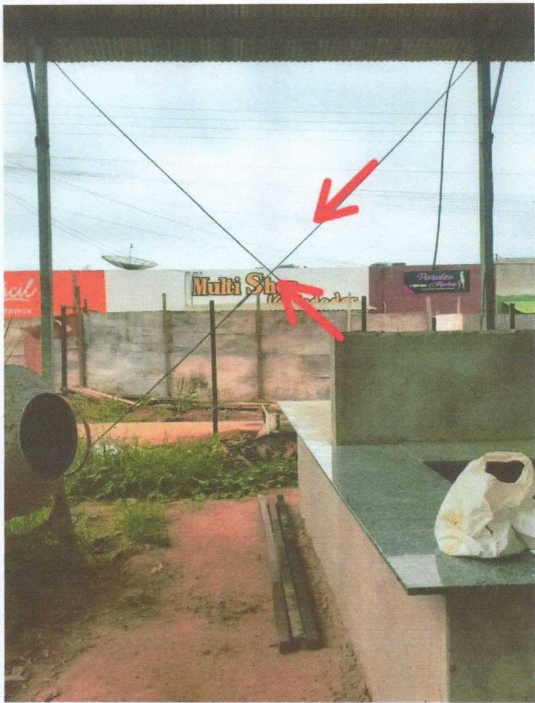
Figura 6: cabos de sustentação da estrutura.
