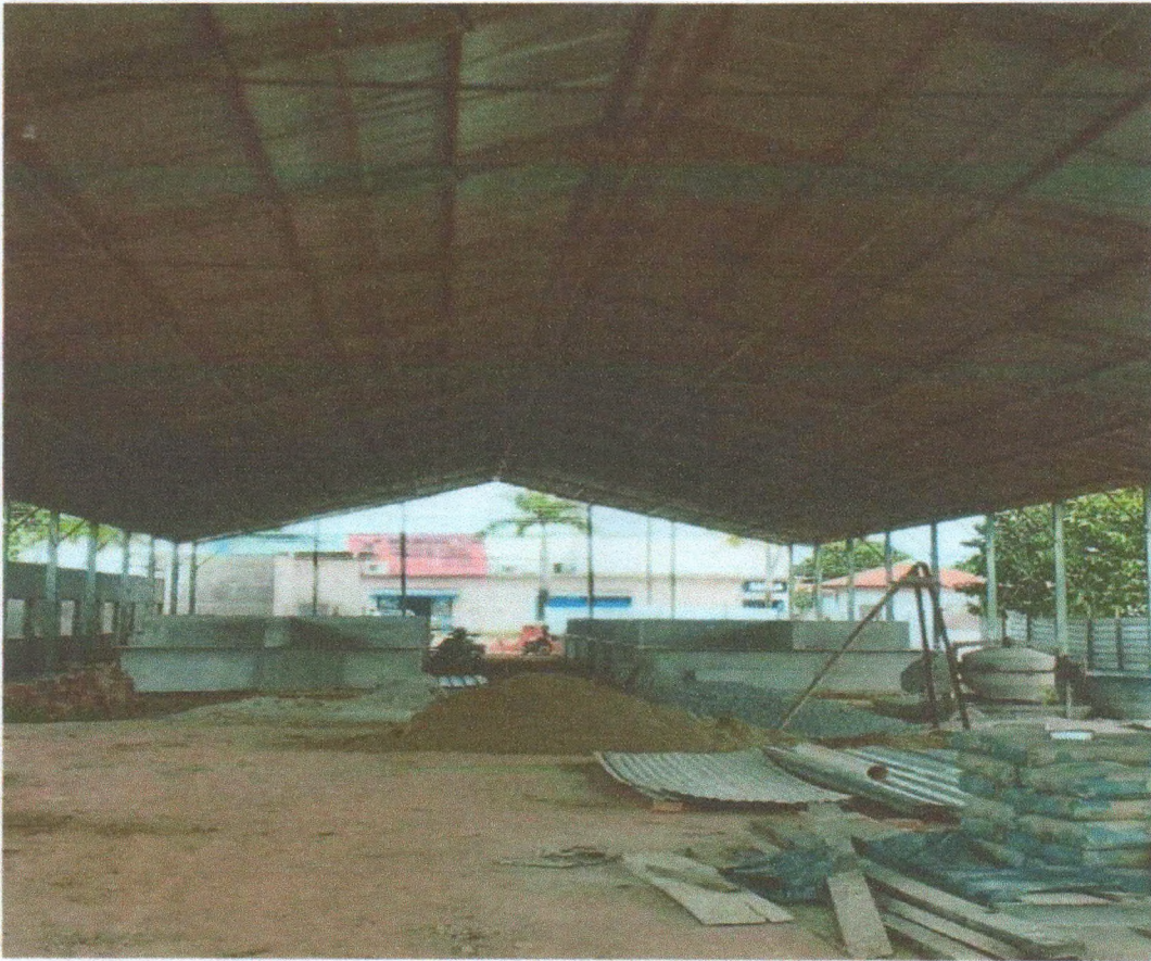
Figura 4. Vista inferior da estrutura.
